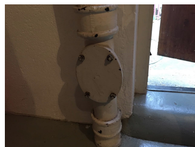
Renslucka på vertikalt rör (se exempel i bilden)
